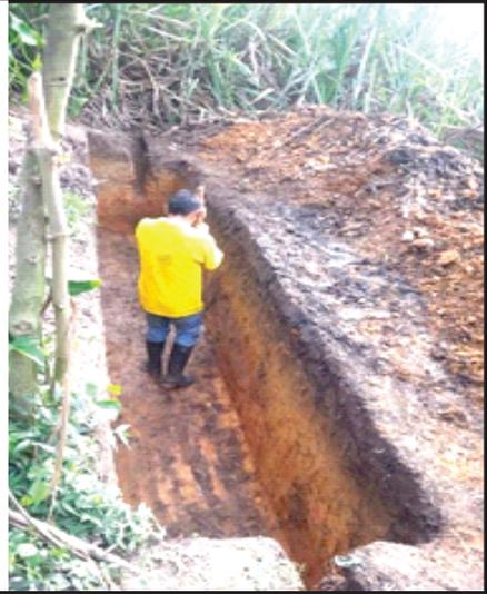
**Foto 2.** Zanja/fosa para plástico de 2 m de ancho que abre a 4 m de circunferencia. Es importante aclarar que en casi el 100% de los casos la zanja/fosa es en tierra totalmente. No es necesario usar concreto, sin embargo, si el terreno es arenoso se puede viga de amarre y pared en bloque o un friso con concreto y suelo de la misma zanja, pero estos son casos excepcionales. Foto tomada por Lylian Rodríguez, en la finca de Cayetano Obregón, Guapotá, Santander, Colombia
