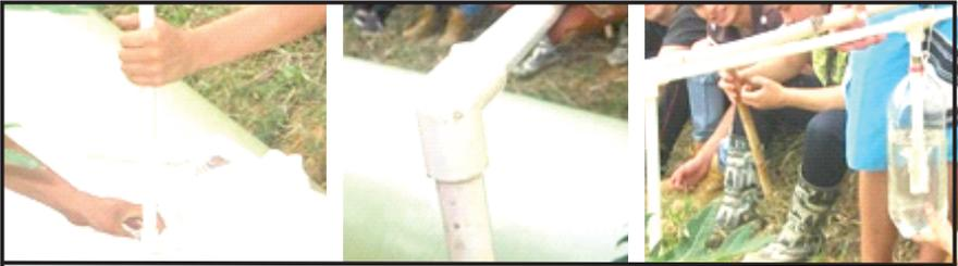
**Fotos 34 a 39.** Tubería de conducción del biogás hasta la válvula de seguridad. Fotos tomadas por Diana Zea, 2016 Tosoly, Santander, Colombia
