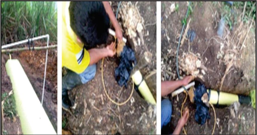
**Fotos 40 a 4** . Una vez terminada la válvula de seguridad y hecho el aforo, se inserta la manguera con agua para llenar hasta cubrir “sellar” los tubos y luego proceder a quitar los plásticos, conectar tuberías, preferiblemente no pegar nada, no es necesario. Posteriormente proceder a lavar los corrales. Fotos tomadas por Lylian Rodríguez, Colombia 2014
