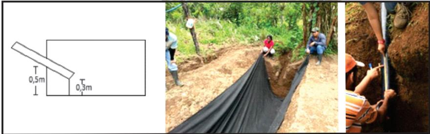
**Figura 1.** Medidas para hacer las zanjas en los extremos para ubicar los tubos. **50 cm del piso para iniciar la excavación con un ángulo aproximado de 35-40 grados asegurando que el tubo queda como mínimo a 30 cm del piso para evitar que se tape la entrada.**
