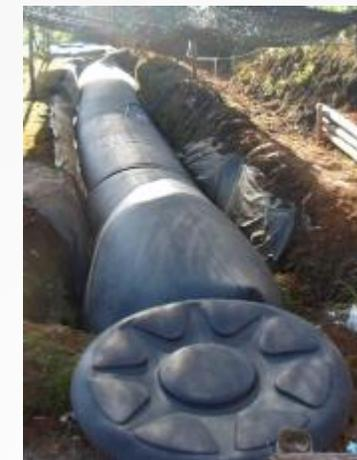
**Fotos:** Tanque de salida de Efluente de 1000 litros, Biodigestor Tubular en Geomembrana.
