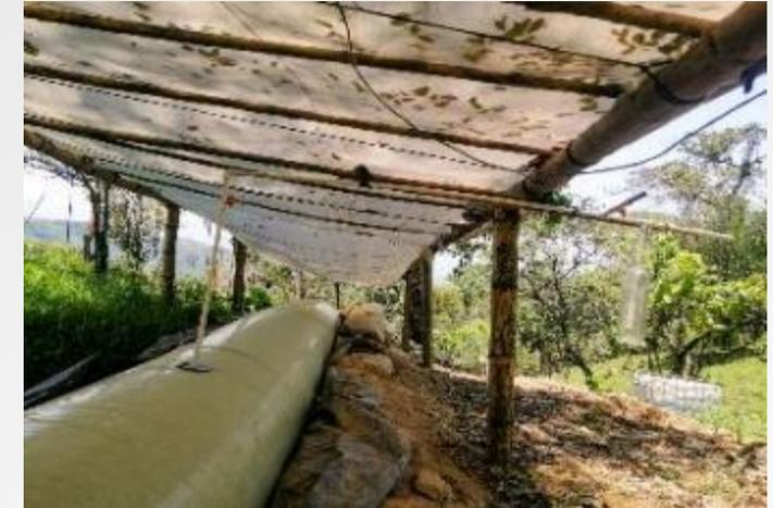
**Foto:** Biodigestor instalado con línea básica de biogás, y techo de protección.
