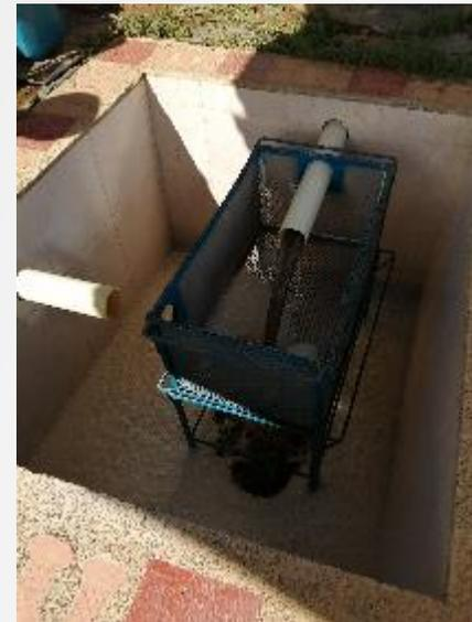
**Fotos:** Paso 1. Filtración de Efluente en malla inoxidable. Muestra de evolución del proceso que antes se hacía con malla antitrips; incluye filtración y área de lavado.
