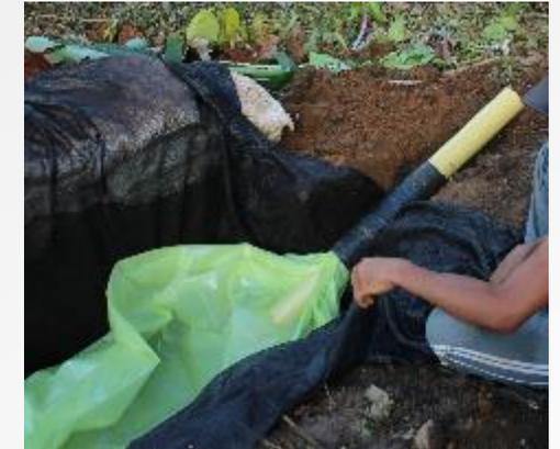
Fotos. Entrada y Salida del Biodigestor puede ser en Tubería o en Tanque.
