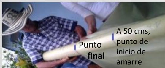
7. De esta forma queda armado el Biodigestor, el cual se recomienda cubrir con polisombra u otro material que lo proteja para ser transportado hasta la fosa o zanja para su instalación.
