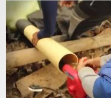
Fotos. Llenado del Biodigestor con Soplador de aire.
