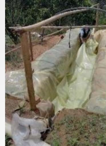
**Ubicación del Biodigestor:** se quitan dobleces laterales, inicia el llenado con aire ayudando a abrirlo; se centra y se ajusta para darle extensión y forma final al Biodigestor.
