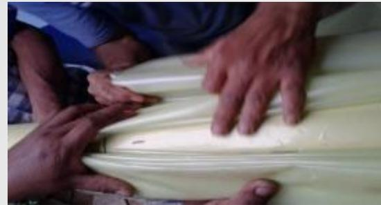
5. Una vez asegurado el tubo con los pliegues, se procede al amarre con tira neumática de 5 cms de ancho y 4 m de longitud, iniciando desde el punto marcado con 50 cms desde adentro hacia afuera. El amarre se hace en espiral bien apretado para evitar fugas y se termina el amarre a los 25 cms, en la marca del punto final.
