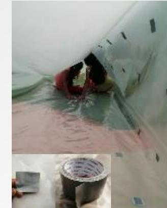
Fotos. Plástico tubular con talladuras y pequeños orificios, recuperado con cinta adhesiva gris para ducto.
