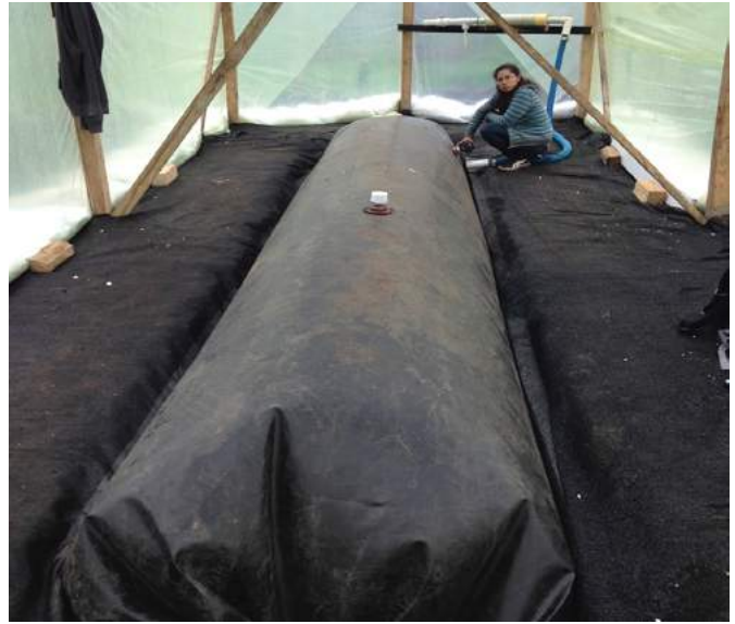
Transición del biodigestor en CIDT con las adecuaciones realizadas.
