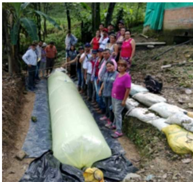
Construcción Biodigestor, aprovechamiento efluente para riego.
