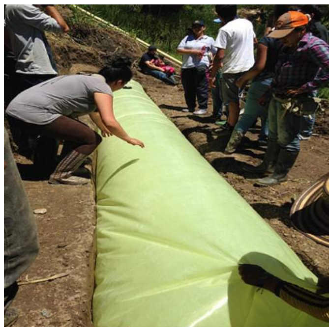
Instalación sistema de biodigestión.
